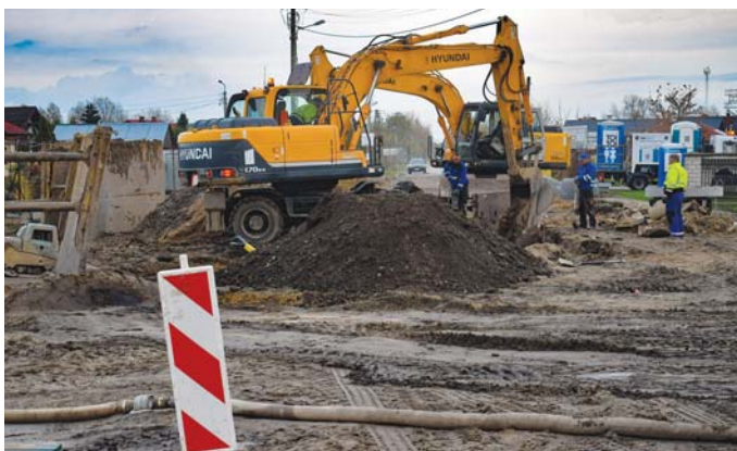
Budowa ronda w Krupiej Wólce
